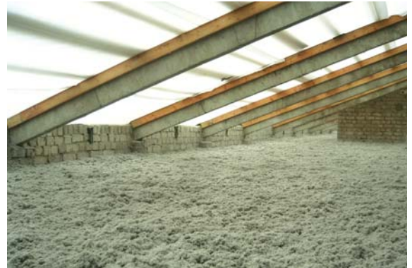
Чердак здания после обработки
